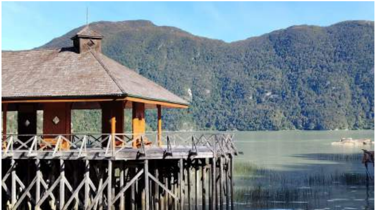
Figura 5. Una de las plazas de Caleta Tortel, construida sobre pilares de madera de ciprés de las Guaitecas. Fotografía: Pamela Maldonado.
