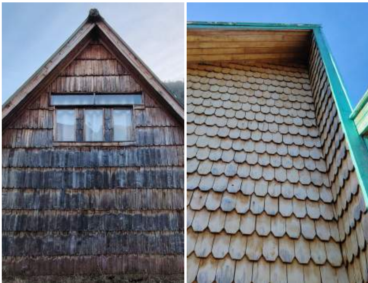
Figura 4. Tejas de madera nativa en construcciones de Caleta Tortel. Fotografía: Pamela Maldonado.
